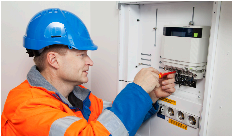
Älykkäiden mittareiden asennustyö ja etäluentajärjestelmän käyttöönotto tapahtuu vaiheittain. Näin etäluennan etuja päästään hyödyntämään jo projektin alkuvaiheessa. Etäluettavat mittarit asentaa Suur-Savon Sähkötyö Oy.
